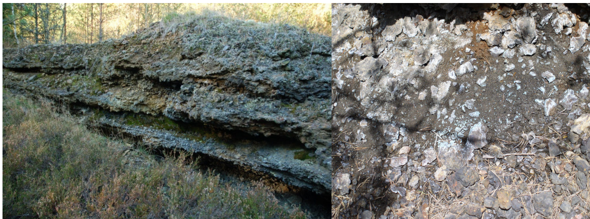
Obr. 62. A - Pohľad na starú haldu metalurgickej trosky pri monitorovacom bode SM8. Materiál trosky je stmelený do kompaktných vrstiev. B - Na povrchu sú dobre viditeľné znaky zvetrávania a rozpúšťania a tvorby solí
