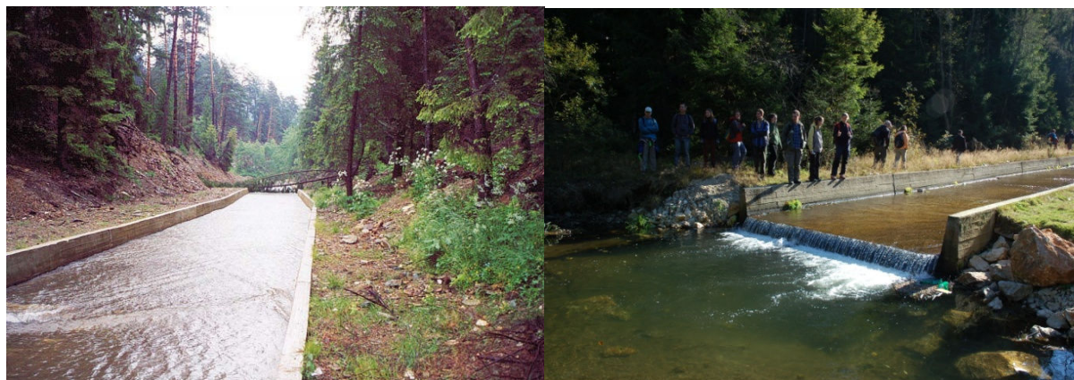
Obr. 9: A „Betónové koryto“ v potoku pri šachte Rothenberg bráni pretekaniu vody do podzemia (stav rok 1999). B – Pohľad na koniec vybetónovaného úseku potoka (2007)
