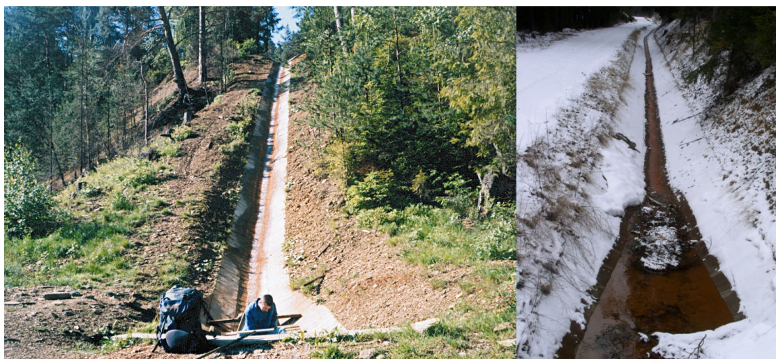
Obr. 10. Drenážne jarky z betónových blokov vybudované v rámci likvidácie bane a rekultivácie v okolí bývalého ložiska. A - V blízkosti križovatky k bytovkám nad baňou - K 1. B - Popri ceste nad bývalým závozom smerom k hlavnej ceste
