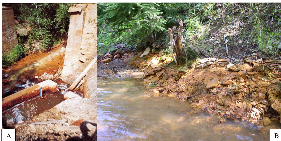
Obr. 23. A – Vyústenie novej drenáže, bod SM2, vybudovanej po zasypaní bane. B – Priesaky banskej vody do potoka s tvorbou okrových zrazenín v blízkosti bodu SM2
