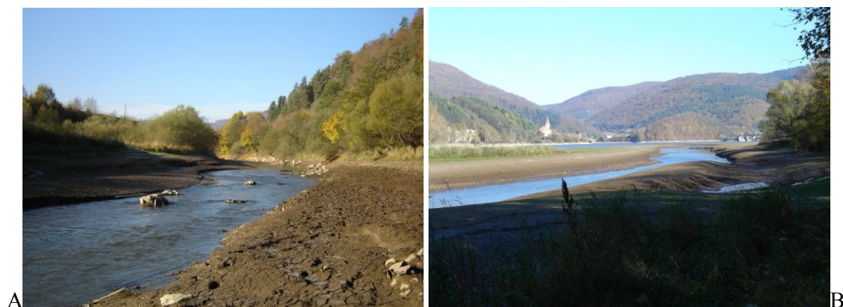
Obr. 16. A - Breh rieky Hnilec v mieste vyústenia do nádrže Ružín s náplavmi. B - Pri nízkom stave vody je dobre vidieť náplavy sedimentov riekou Hnilec, ktoré postupne zanášajú nádrž a tiež eróziu uložených sedimentov tokom (október 2006)
