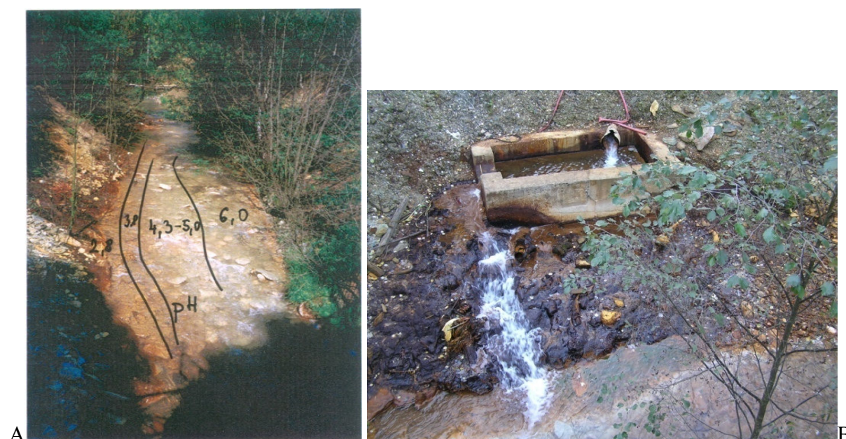
Obr. 8. A - Priesaky kyslej vody do potoka Smolník, rok 1995 (Šucha et al. 1996). B - Vyústenie novej drenáže (SM2), stav v roku 2007
