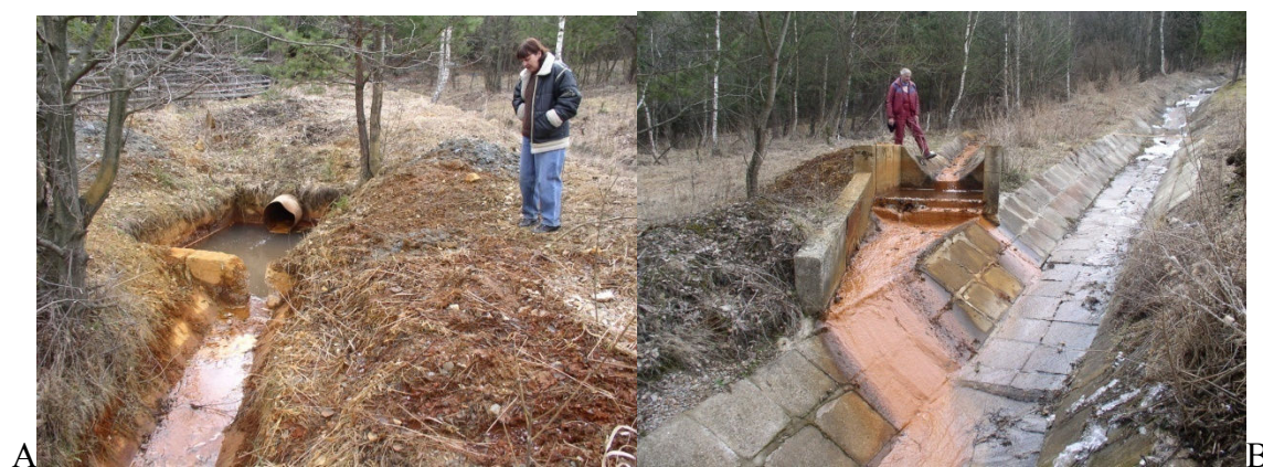
Obr. 41. Tvorba zrazenín z drenážnej vody odkaliska. A - Ľavá strana s akumuláčnou nádržou na zachytávanie kalu. B- Pravá strana s hydrometrovací žľabom. Zrazeniny sa ďalej miešajú a odtekajú do potoka
